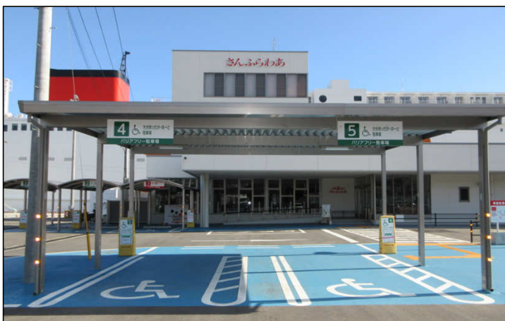
フェリーターミナル 屋根付きのスルー型駐車スペース
