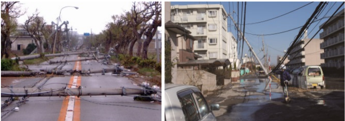
図 2.2 倒壊した電柱による道路閉塞
