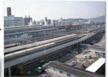
高架が完了したJR姫路駅
