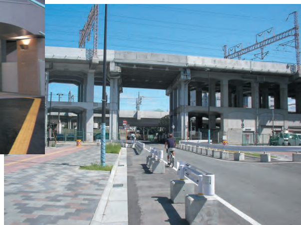
整備が進む内々環状西線
