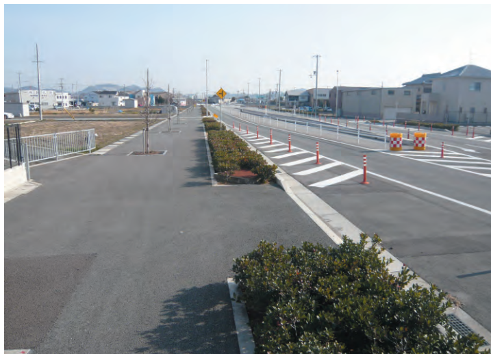
整備が進む幹線道路（大日線）
