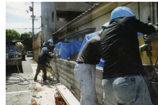
危険ブロック塀の撤去作業
