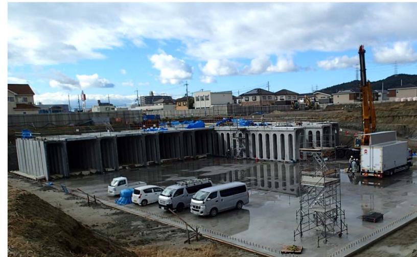
雨水貯留施設施工例(糸引公園)
