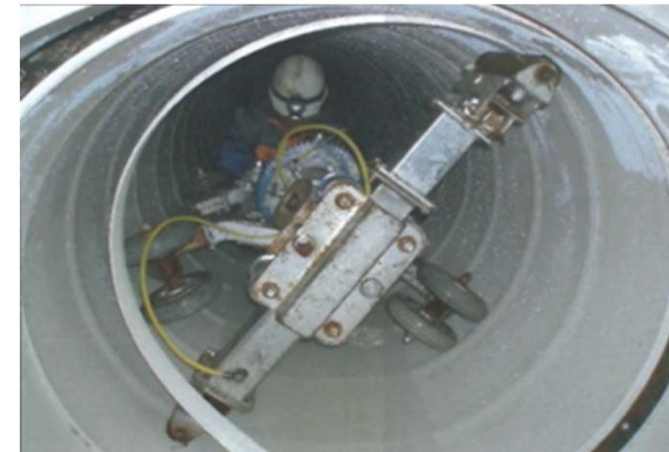
老朽管更生工事の作業状況
