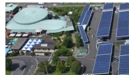
太陽光発電施設の設置
