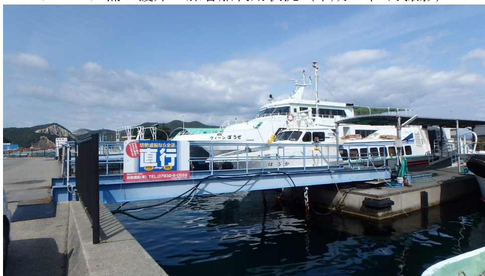
カマスガ浦D護岸 旅客船利用状況（平成29年4月撮影）
