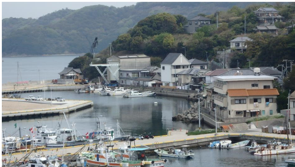
奈座新港 係船岸、用地整備予定箇所現況（平成29年4月撮影）
