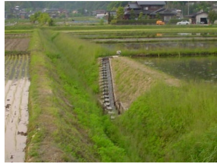
写真. 階段式魚道 (豊岡市事例)
