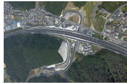
夢前スマートインターチェンジ
