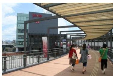
姫路駅前の連絡デッキ
