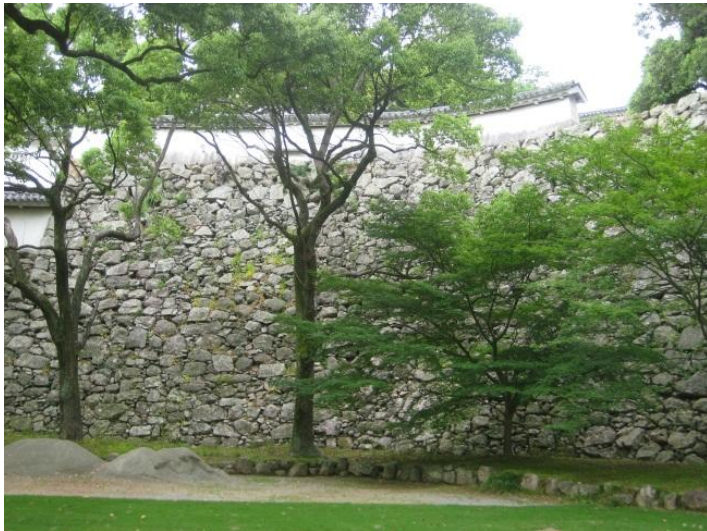
二の丸北方：特徴的なアーチ型の輪取り野面石垣
