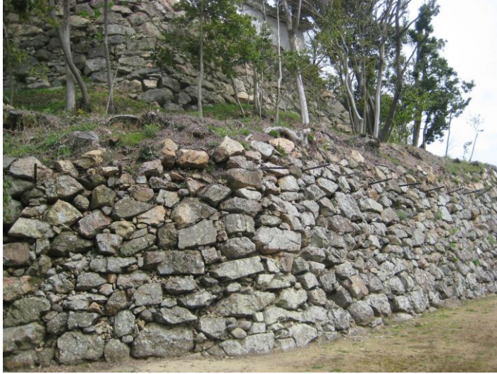
上山里曲輪：二段積みのシノギ積み野面石垣
