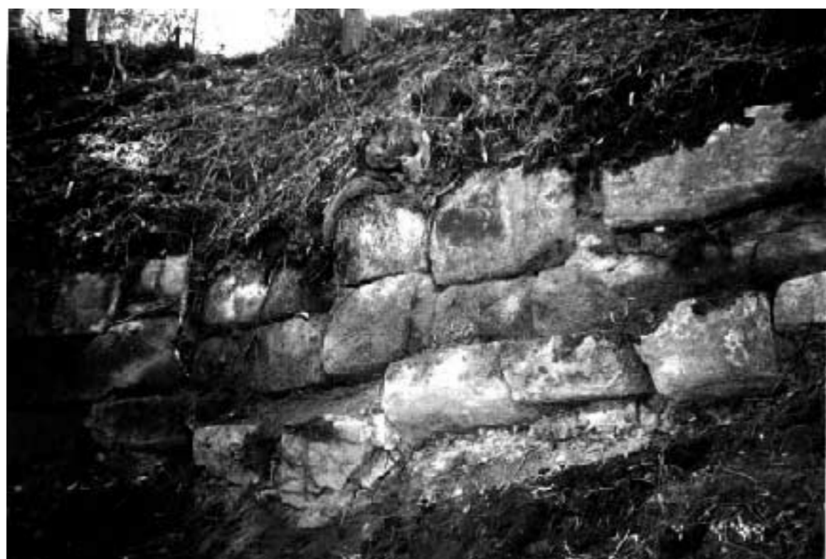
城壁の一部；切石の基壇上に土塁が構築されている
