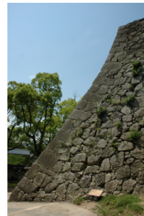
II期 備前丸西側の石垣(「扇の勾配」)
