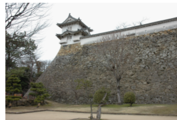
III期 西の丸南面の石垣
