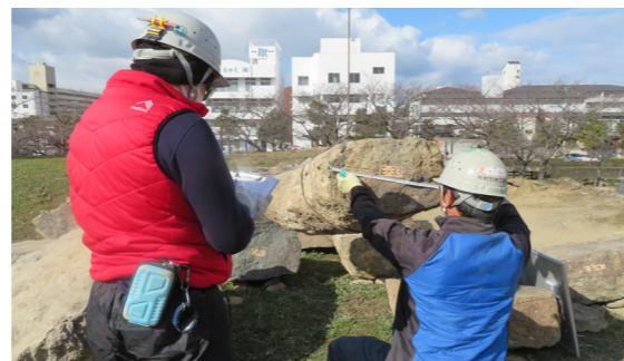
④【石材調査】解体した石材は、大きさ、種類、状態などを細かく観察して記録します。
