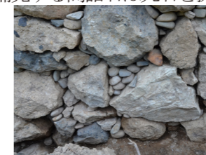
発掘調査で確認した間詰石 (内船場蔵南石垣)
