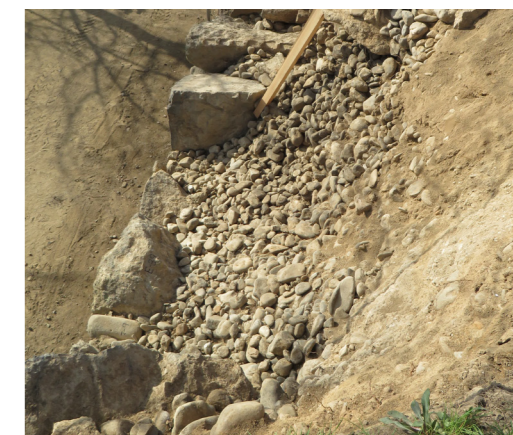
車門石垣の裏込め
