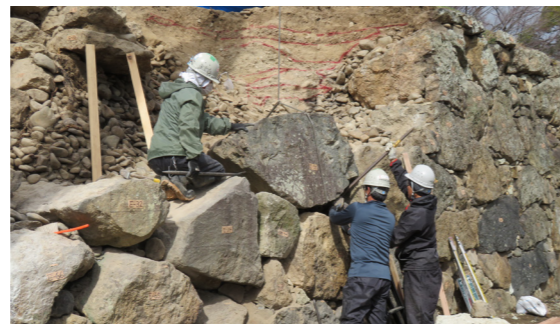
⑥【積直し・復旧】全ての調査が終了した後、築石を元の状態に積直し、復旧していきます。
