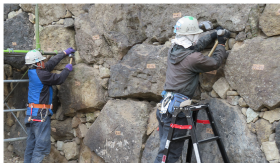
⑦【積直し・復旧】最後に間詰を行います。石の脱落が目立っていた場所は、新しく補充します。
