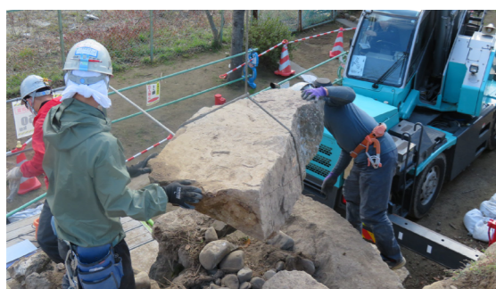
③【解体】1石ずつ取外しながら、下の石との重なり方も記録します。石は仮置場で保管します。
