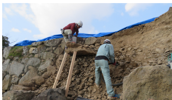
⑤【内部の発掘調査】裏込めや盛土など、石垣の築造過程についても調査します。
