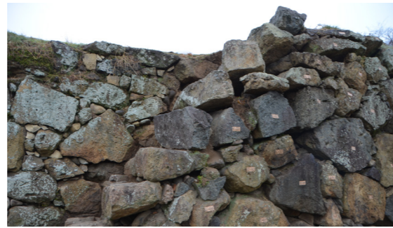
②【石材番号の附番】解体前に石材1点ずつに番号を付けます。元通りに積み直すため、測量図にも同じ番号を記しておきます。
