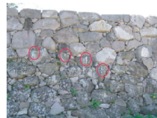
石垣では、修復された部分とオリジナルな部分の境目に鉛板が挟まれている（○印）。
