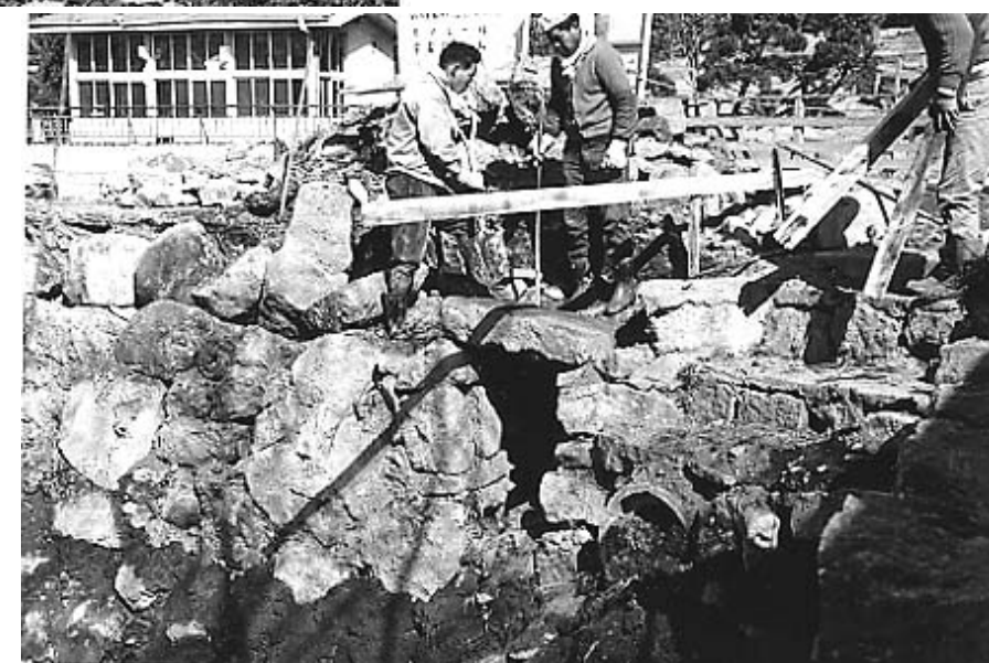
北側の石垣中から出土した暗渠の遺構（上記のカラー図版のx印の箇所）。絵図門と菊門をつなぐ土橋の下に埋設されていた通水溝とみられる。
