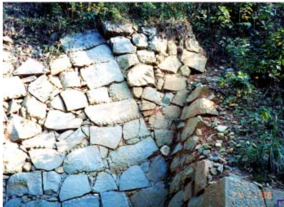
地中から姿を出した富岡城の石垣(二の丸西面)
