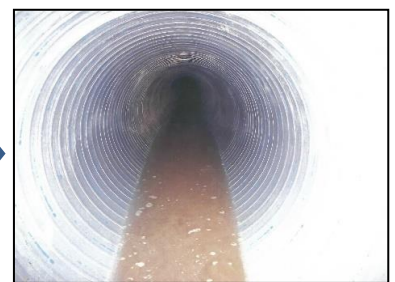
更生後の下水道管
