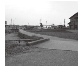
室津道の八枚橋
