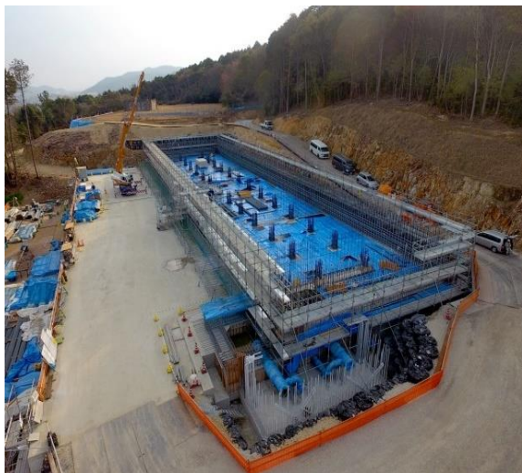
甲山低区第2配水池建設状況
